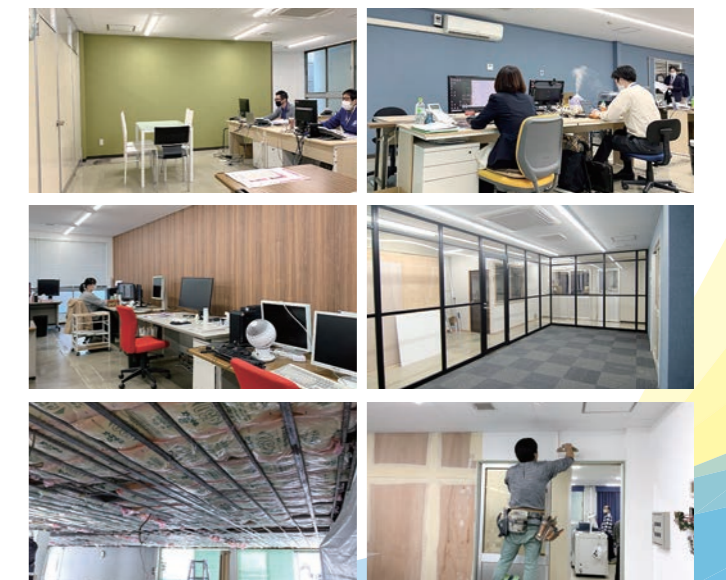
こちらは天井を貼り換え!
